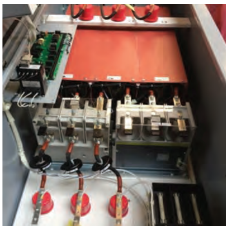
پروژه فولاد مبارکه اصفهان
