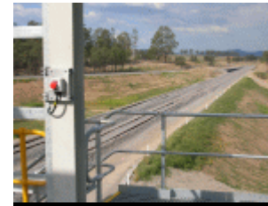
Stazione di scarico/ Unloading station
